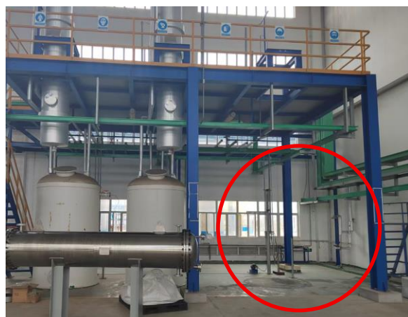
生产设备拆后车间现状图
