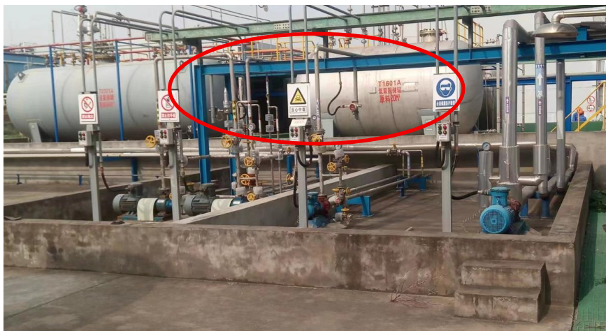
拆迁氢氟酸罐场地现状图
