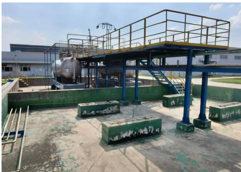
拆迁氢氟酸罐后场地现状图
